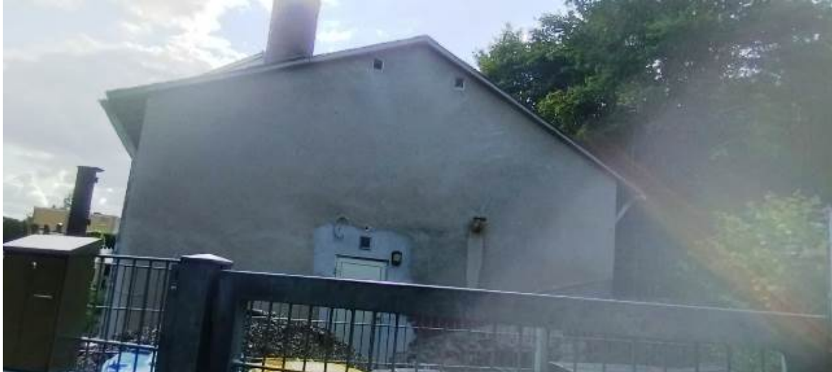
Best. Gebäude – Ansicht Ost
