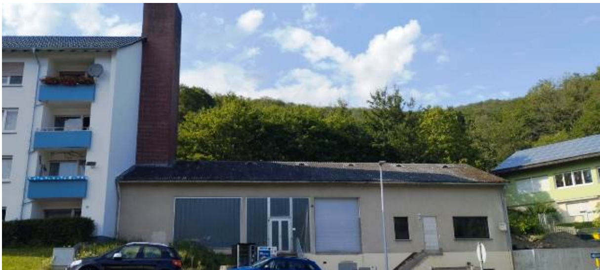
Best. Gebäude Straßenansicht – mit Nachbarbebauung
